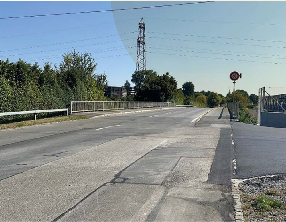
Blegibrücke vor den Instandsetzungsarbeiten
