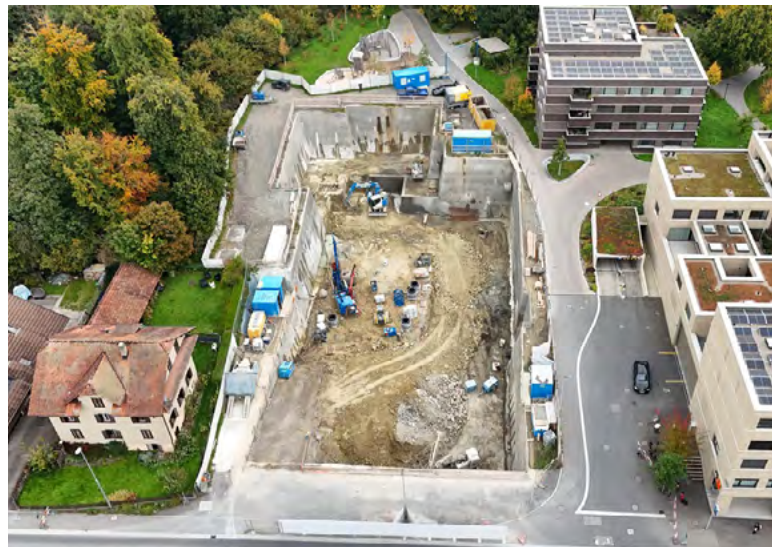
Aushub Gemeinde- und Mehrfamilienhaus
