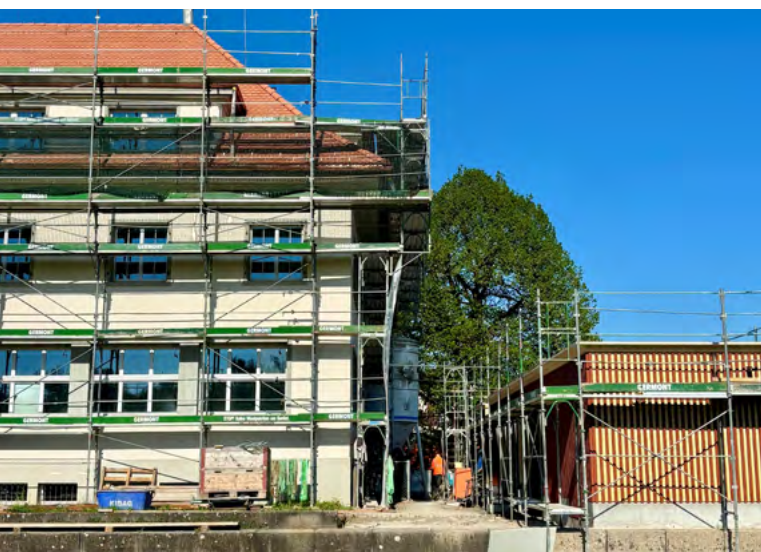
Sanierung Schulhaus Matten
