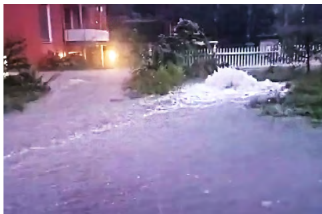
Dorfstrasse, Trennbauwerk überlastet, 1. Sept. 2025
